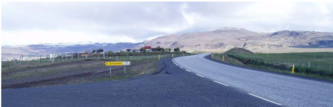
Mynd 3-1 Horft frá Arnarbælisvegi (375) vestur að Kotstrandarkirkju. Suðurlandsvegur verður færður til norðurs og vegurinn hér nýttur sem innansveitarvegur (mynd Efla).
